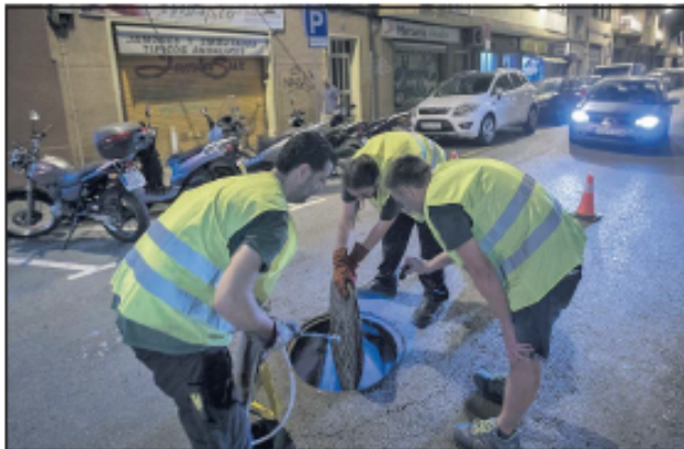
Trabajos de limpieza de un drenaje en un barrio de la ciudad de Barcelona.
